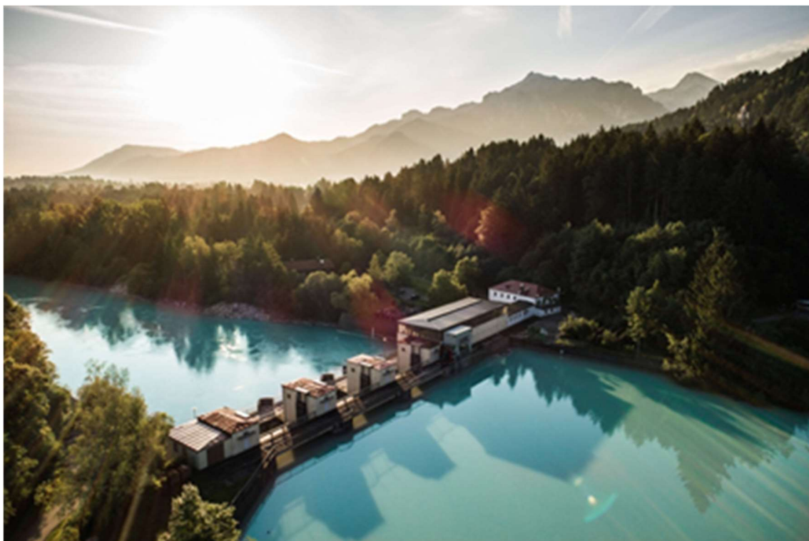
Wasserkraftwerk Horn des AÜW bei Füssen (Allgäu)
